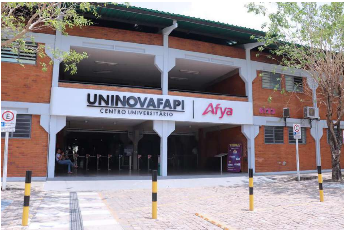
Figura 46 - Fachada Principal do Prédio de Aulas
