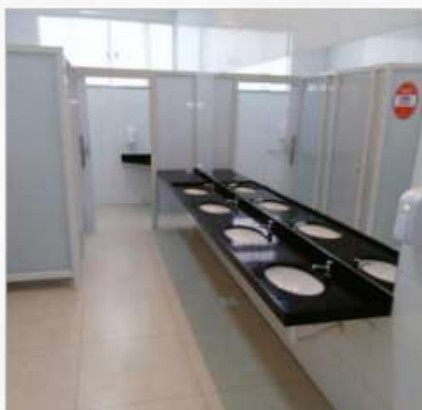
Reforma dos Banheiros
