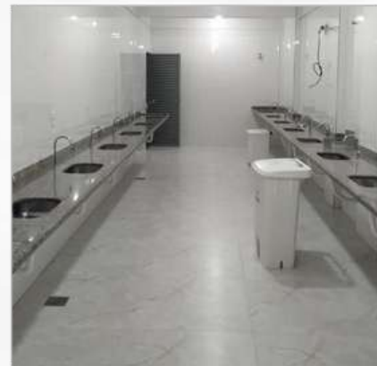
Reforma do Expurgo
