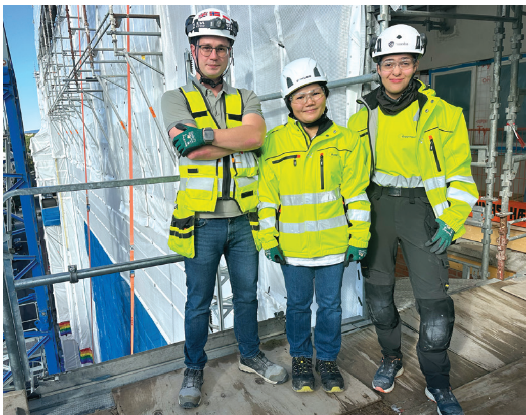
BYGGIMPULS-SKOLEN. Augustyn Topolski har ingeniørutdanning og nå også fagbrev, Nareerat Nongprue er fagarbeider og Isabella Bahson lærling i Byggimpuls.
