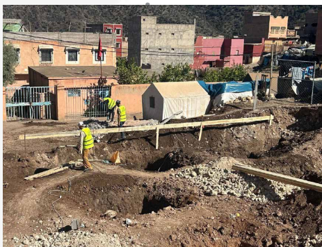
Lancement du chantier de construction d'un centre communautaire et d'une crèche à Moulay Brahim.
