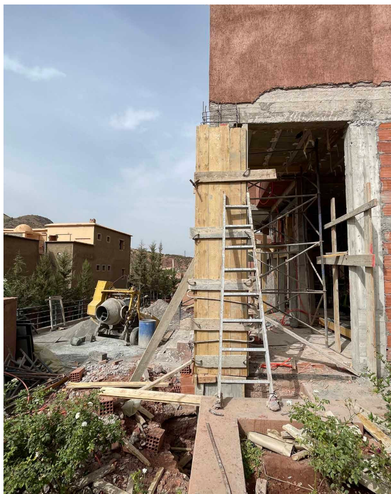
Renforcement structurel de l'internat pour plus de 50 jeunes filles à Asni.
