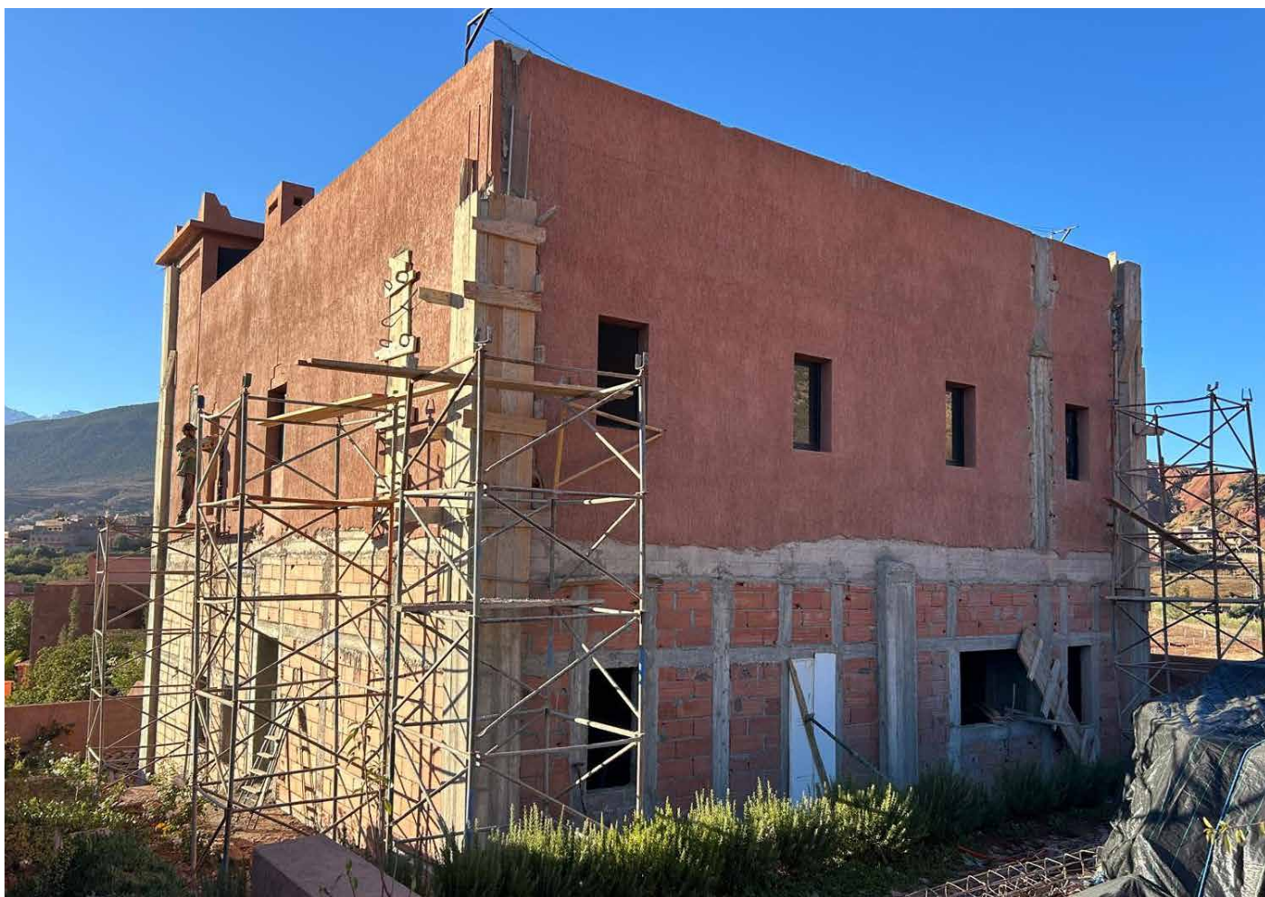
Aperçu des façades de l'internat à Asni en cours de renforcement parasismique.
