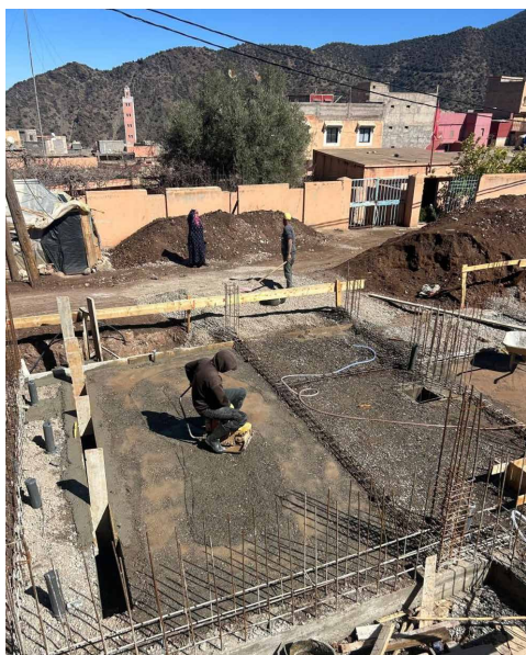
Mise en oeuvre des fondations du centre communautaire à Moulay Brahim.
