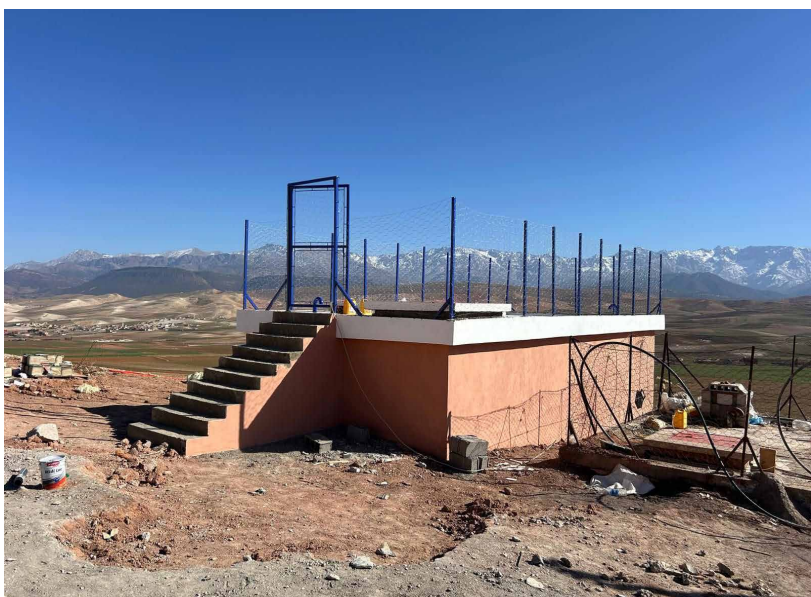
Réalisation des finitions du réservoir de 100 m 3 à Moulay Brahim.
