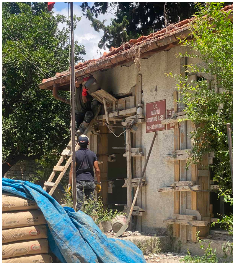
Mise en oeuvre de renforts structuraux parasismiques en béton dans le cadre de la réhabilitation de la coopérative pour femmes.
