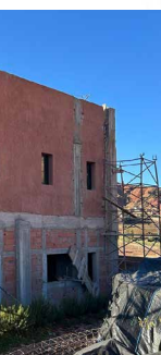
antier de internat
