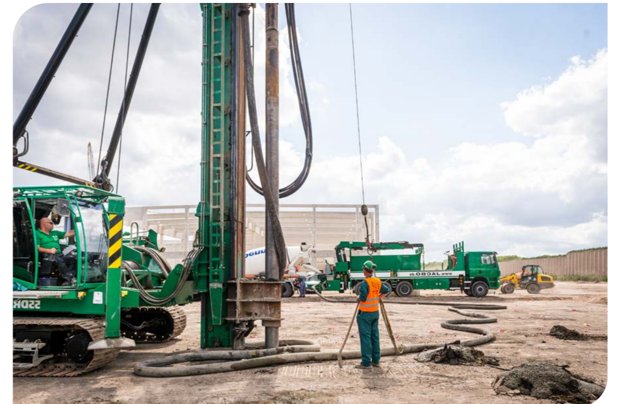
Die neue Woltman 130DR – Digitale Präzision und maximale Reichweite für anspruchsvolle Tiefgründungsarbeiten
