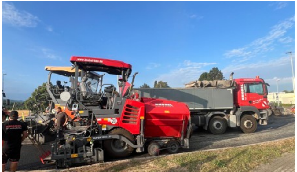
Mit schwerem Gerät zur neuen Fahrbahn: Zwei Abschnitte auf der B3 wurden saniert
