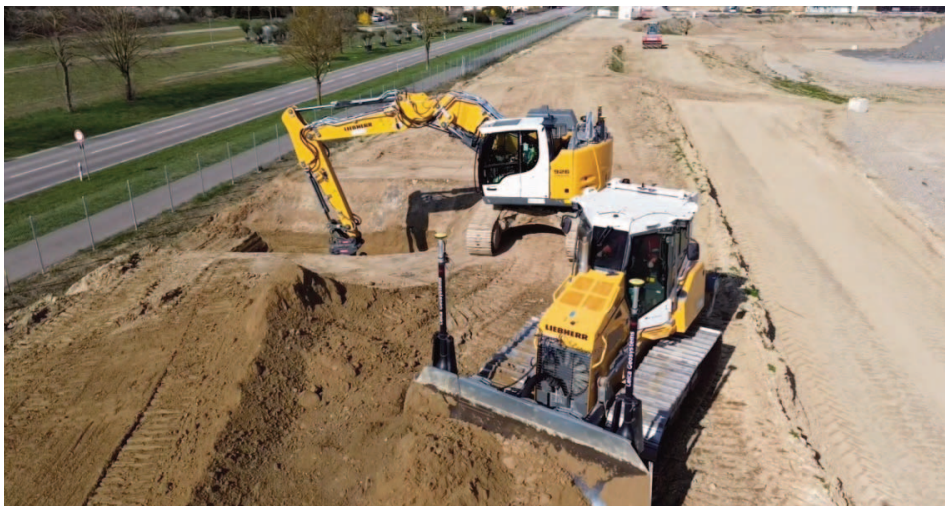
Große Liebherr Maschinen im Einsatz auf der Bauschuttdeponie in Eschbach
