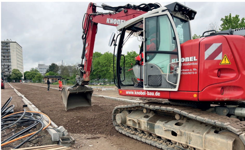
Das KNOBEL-Bauteam mit schwerem Gerät vor Ort im Freiburger Baugebiet Kleinscholz
