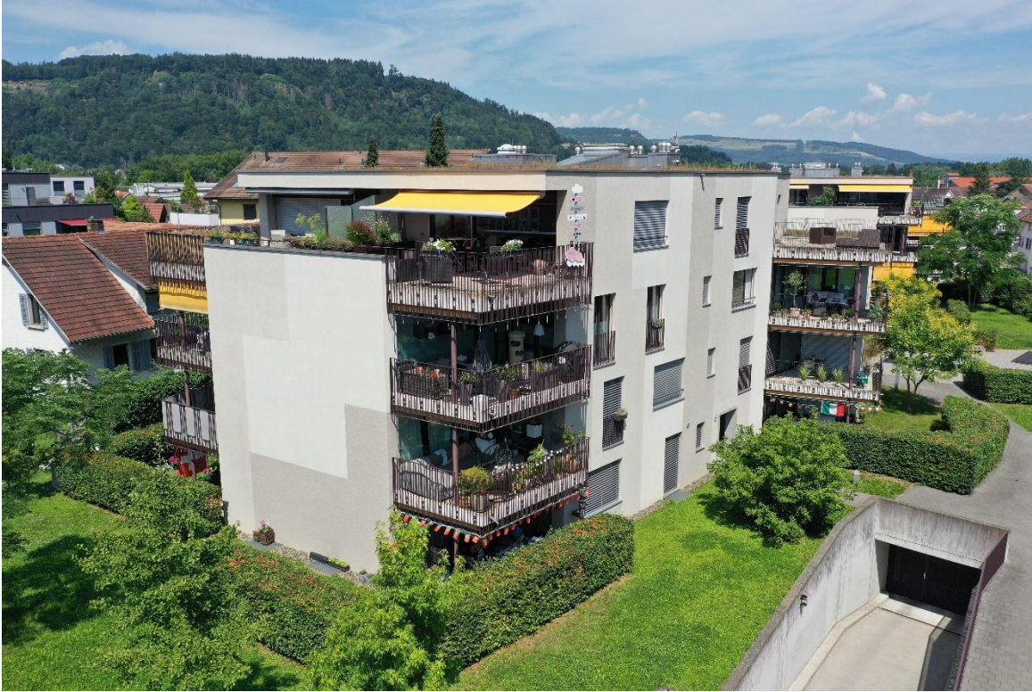
Aufnahme Liegenschaft Vogelsang AG, Schulstrasse 4-8
