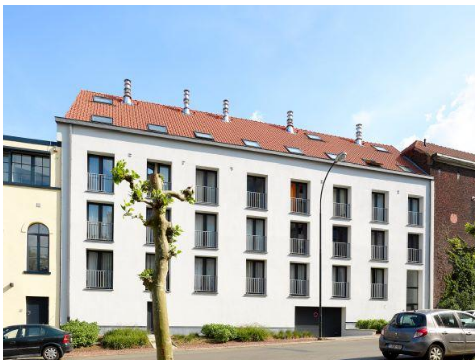
Immeuble Bon Pasteur à Evere
