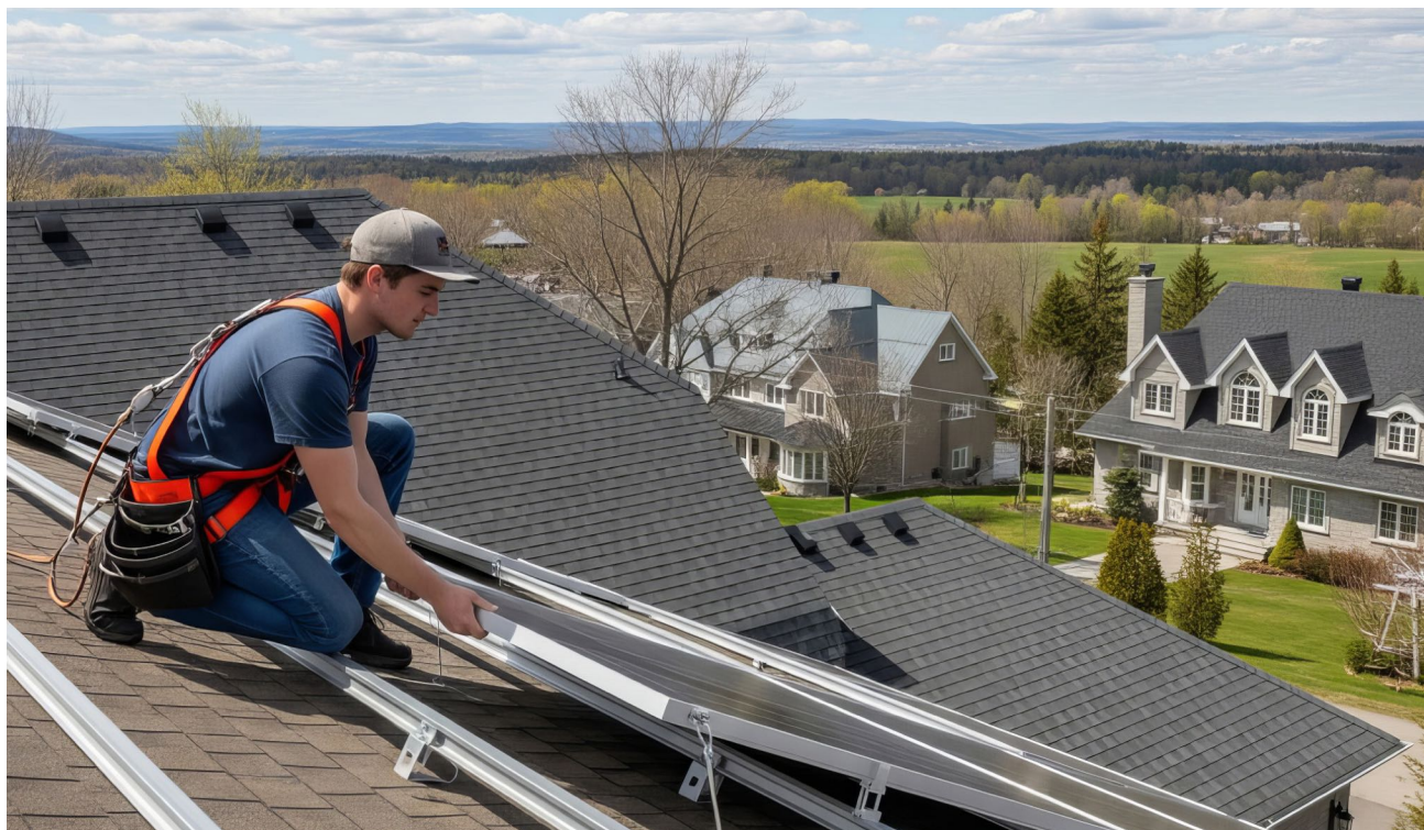
Installateur à l'œuvre : Crédit ESQ
