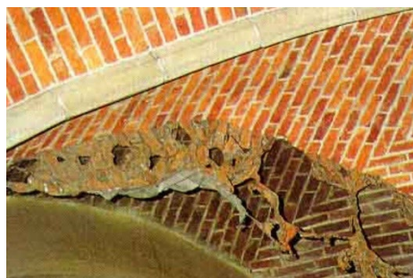
Nettoyage de brique
