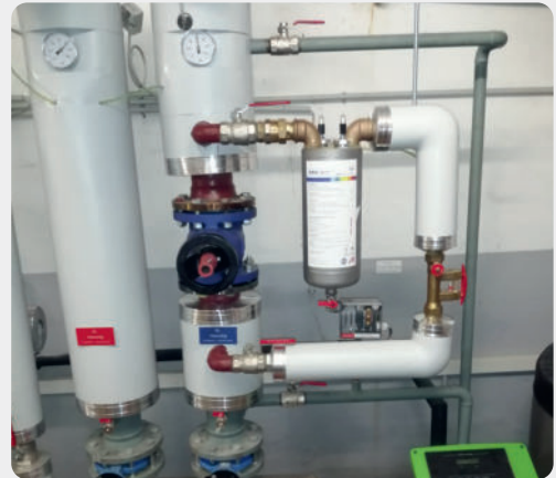
Beispiel Einbau ewo ACTIV mit Bypass-Montage
