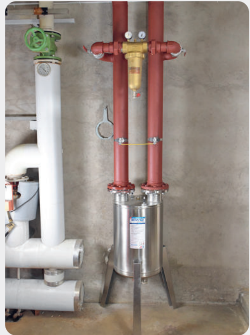
Beispiel Einbau ewo ACTIV für Bestands- und Sanierungsanlagen mit Heizungsschutzfilter im Teilstrom
