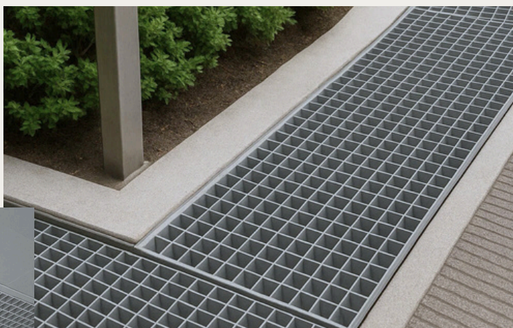
排水溝グレーチング
