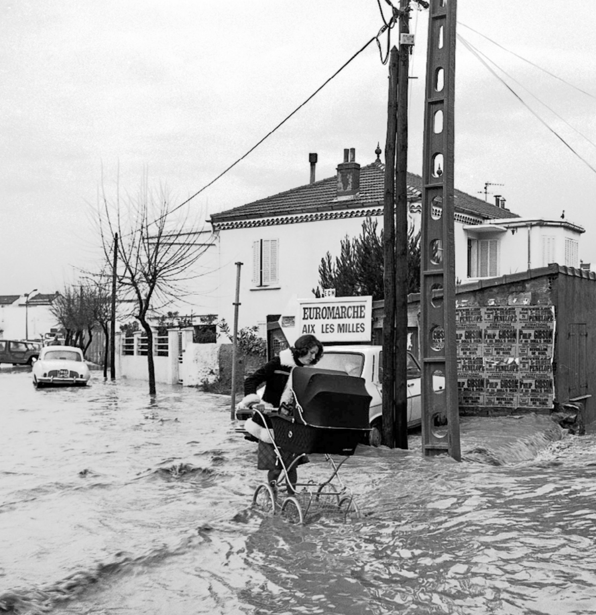
Berre l'Étang pendant la crue de l'Arc en janvier 1978
