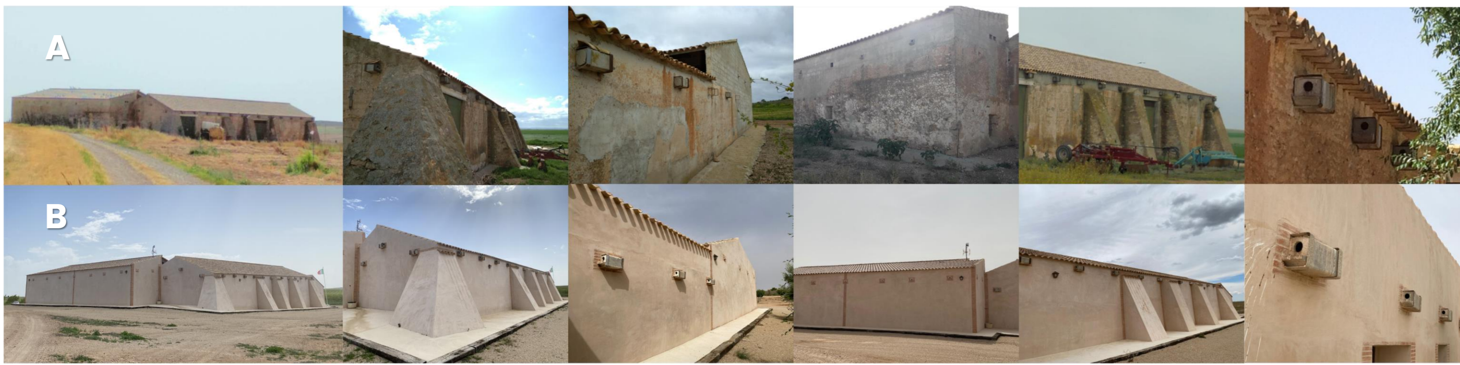
Figura 1. Situación de la colonia "Casa Gualda". A) Previo a restauración. B) Posterior a restauración.
