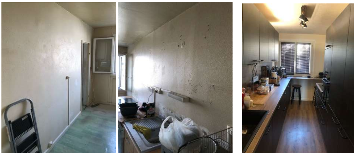
Figure 20 : Photographies de la cuisine et de l'entrée avant / après
