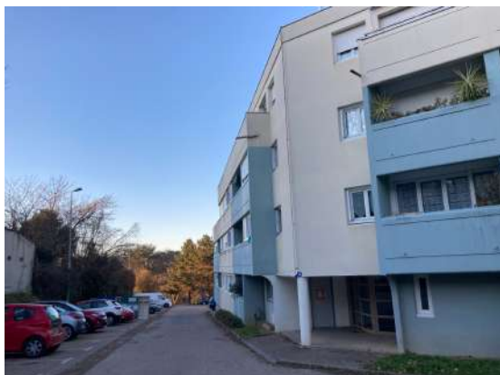
Figure 1 – Photographies des extérieurs et abords de la résidence Les Rênes
