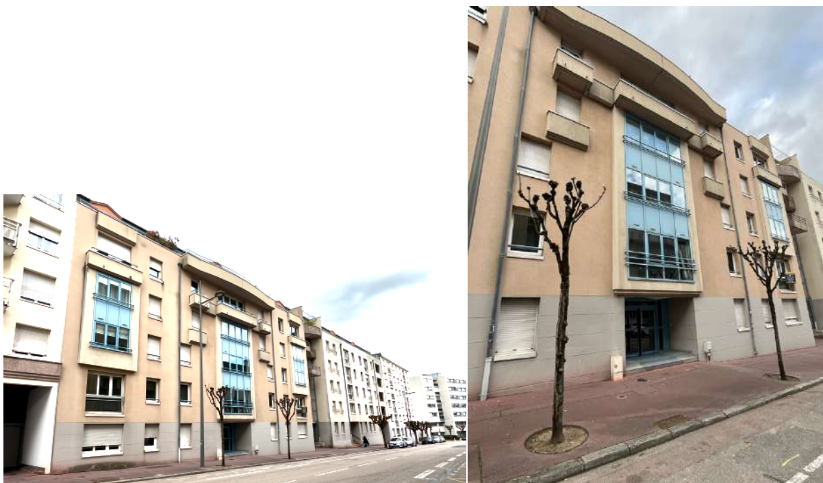
Figure 18 : Photographies des façades extérieures de la résidence
