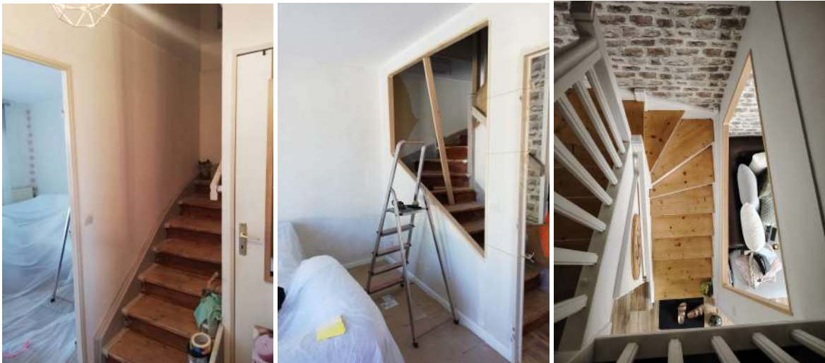
Figure 19 : Photographies des travaux effectués dans l'escalier
