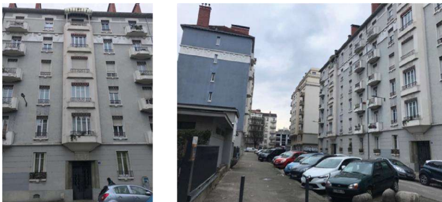
Figure 65 : Immeuble de 1934, près du centre-ville de Grenoble, où quatre logements T3 sont vendus en 2019 Auteur : Tiphaine Combaz, janvier 2023
