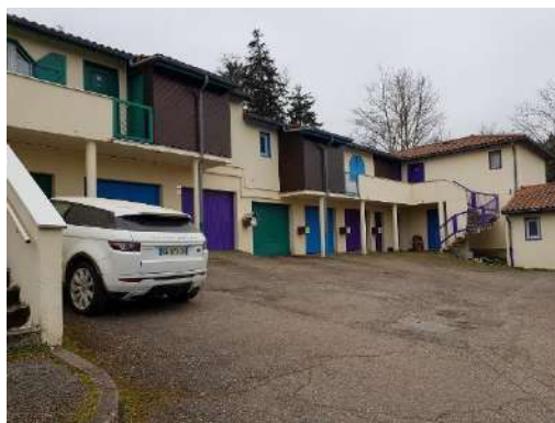
Figure 75 : Vente HLM dans la résidence Arc-en-ciel à Amplepuis Auteur : Lydia Coudroy, 2022
