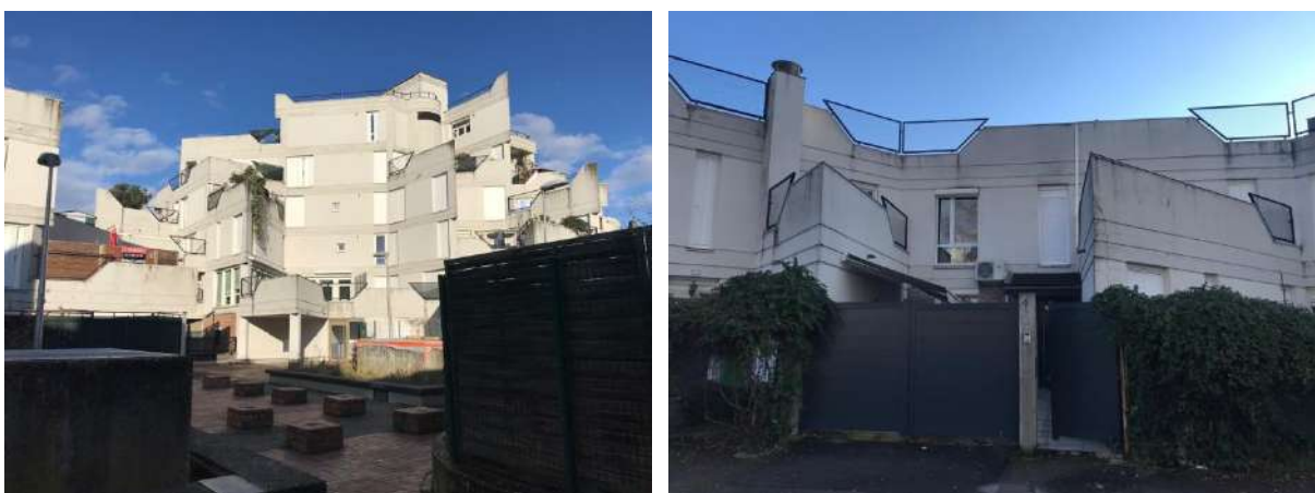
Figure 68 : L'ensemble Renaudie à Saint-Martin-d'Hères Photo : Tiphaine Combaz, janvier 2023
