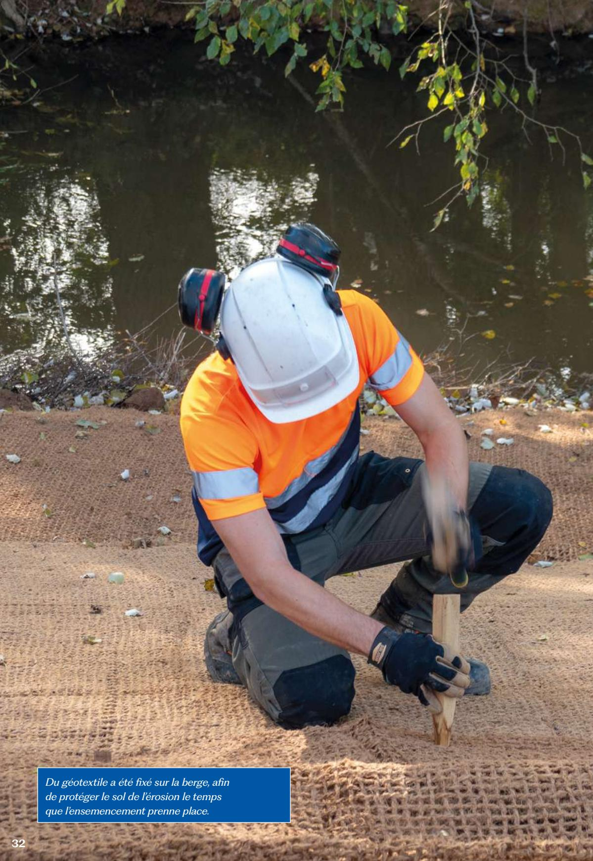
Du géotextile a été fixé sur la berge, afin de protéger le sol de l'érosion le temps que l'ensemencement prenne place.
