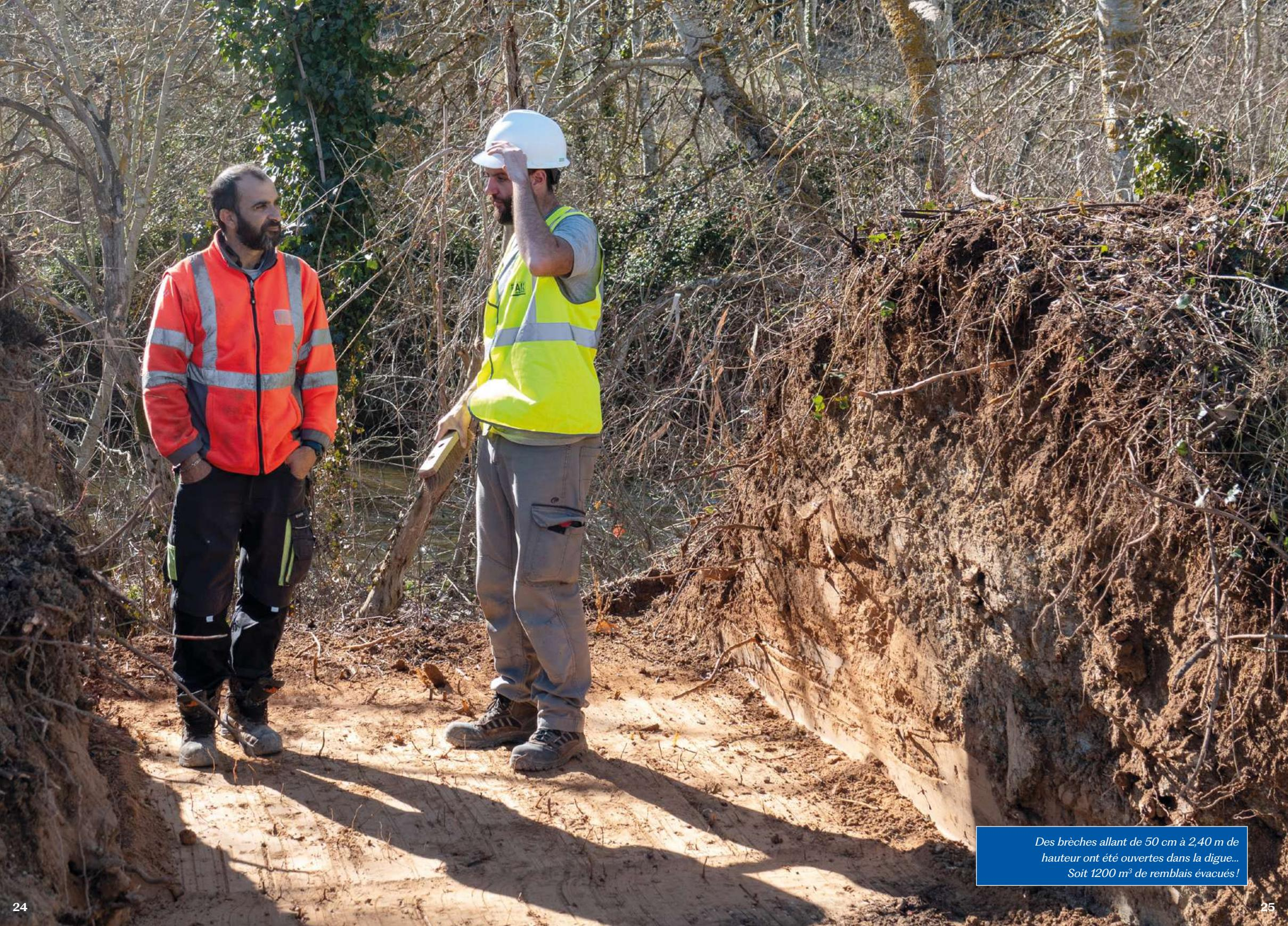
Des brèches allant de 50 cm à 2,40 m de hauteur ont été ouvertes dans la digue... Soit 1200 m<sup>3</sup> de remblais évacués!
