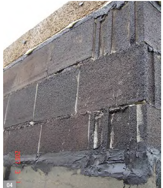
Abb. 03 und 04: Schadenbeispiele für Abdichtungen an erdberührten Bauteilen [Foto: ofi]
