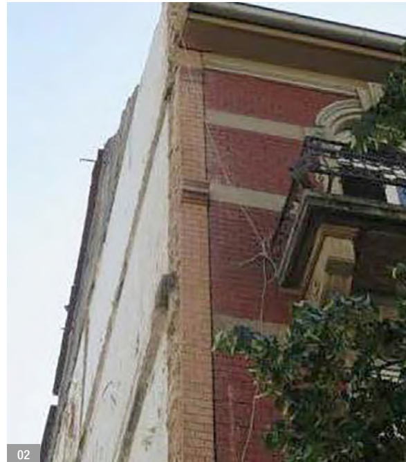
Abb. 02: Ehemalige Kommunwand, »neue« Giebelwand des Nachbargebäudes
