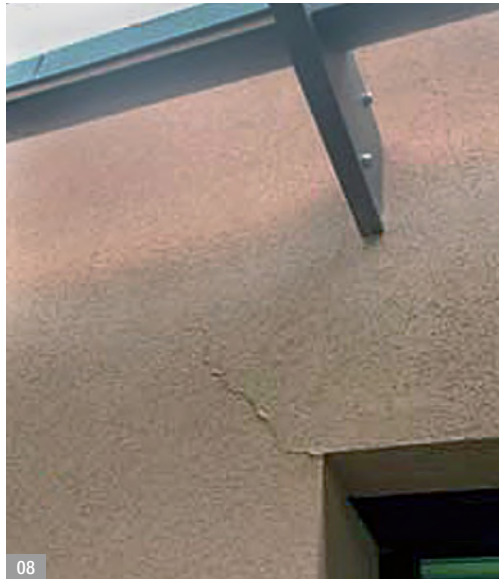
Abb. 07 und 08: Häufiger Schaden: Ecken von Fensterlaibungen ohne Verstärkung zum Beispiel durch ein Vlies oder ohne L-förmigen Zuschnitt der Dämmplatte [Foto: AQC]
