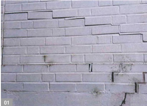
Abb. 01: Diagonal abgetreppte Rissbildungen im Verblendmauerwerk
