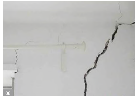
Abb. 06: Teilabriss der angrenzenden Fassaden-/Außenwandbereiche
