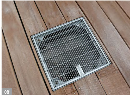
Abb. 08: Unbeschädigtes Entwässerungselement
