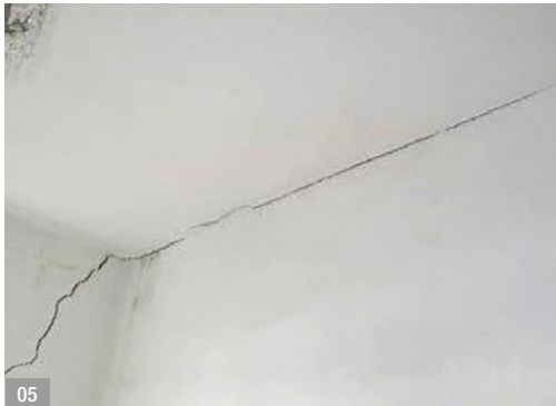
Abb. 05: Abriss der Geschossdecke von der Wand
