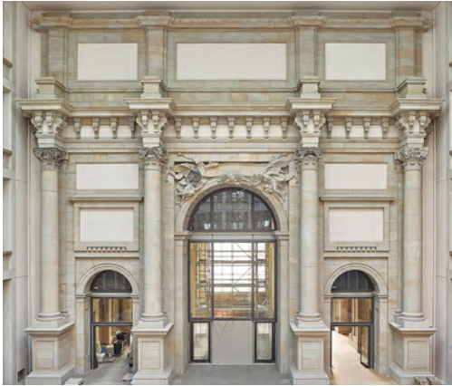
Abb. 02: Eosander-Portal im Foyer [Foto: Falk Lange]
