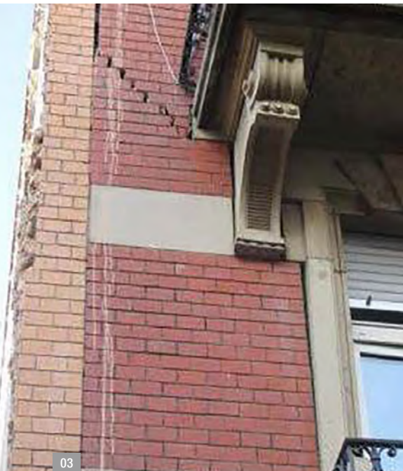
Abb. 03: Teilabriss der Wand
