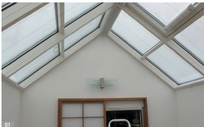
Abb. 01: Blick in das Galeriegeschoss mit dem verglasten Dachfirst
