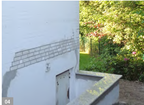
Abb. 04: Sanierte Gebäudeecke mit Blick auf den gelichteten Baumbestand
