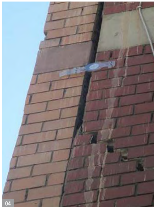
Abb. 04: Teilabriss der Wand
