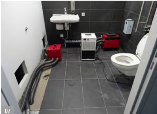
Abb. 07: Geräte zur technischen Trocknung in einem Sanitärraum
