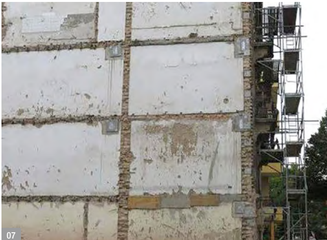
Abb. 07: Neue Verankerung der Wand mit den Geschossdecken
