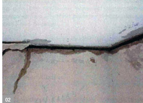
Abb. 02: Teilabriss der Kelleraußenwand von der Kellerdecke
