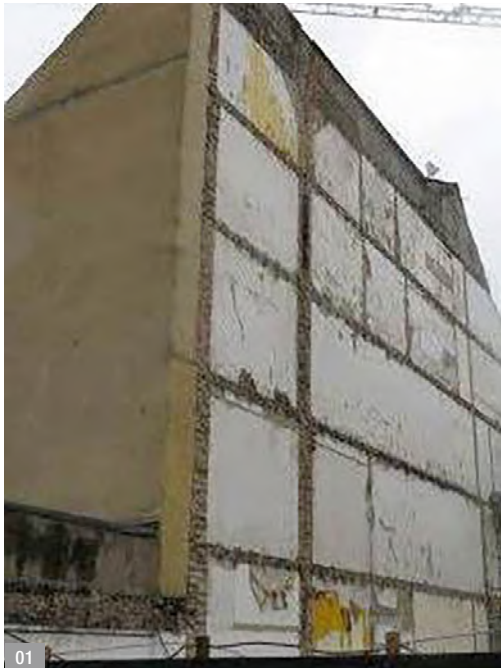
Abb. 01: Ehemalige Kommun- bzw. ursprüngliche Giebelwand des abgebrochenen Gebäudes
