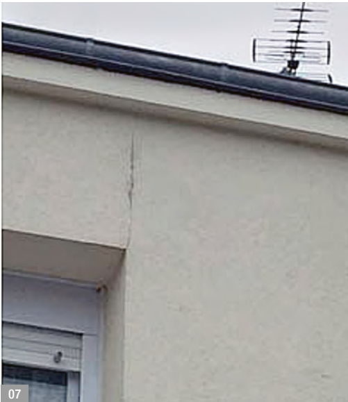
Abb. 07 und 08: Häufiger Schaden: Ecken von Fensterlaibungen ohne Verstärkung zum Beispiel durch ein Vlies oder ohne L-förmigen Zuschnitt der Dämmplatte [Foto: AQC]
