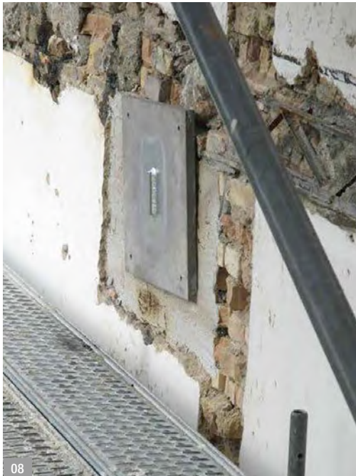
Abb. 08: Neue Verankerung der Wand mit den Geschossdecken
