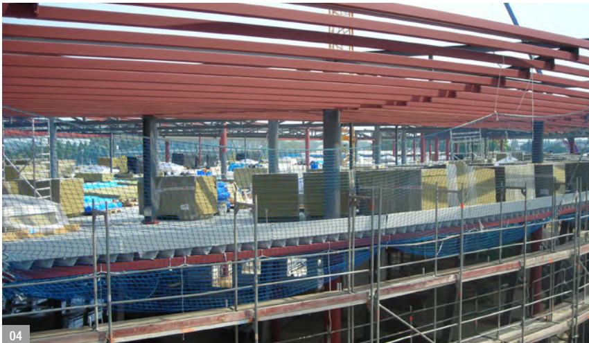
Abb. 04: Baustelle eines Gewerbeobjekts [Foto: T. Sell]
