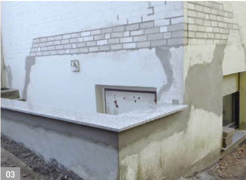
Abb. 03: Neu erstelltes Außenmauerwerk
