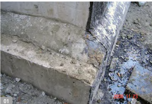
Abb. 01 und 02: Schadenbeispiele für Abdichtungen an erdberührten Bauteilen [Foto: ofi]
