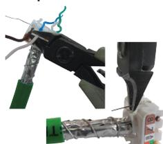
Couper les fils au raz du passe fils et couper le drain\*.
