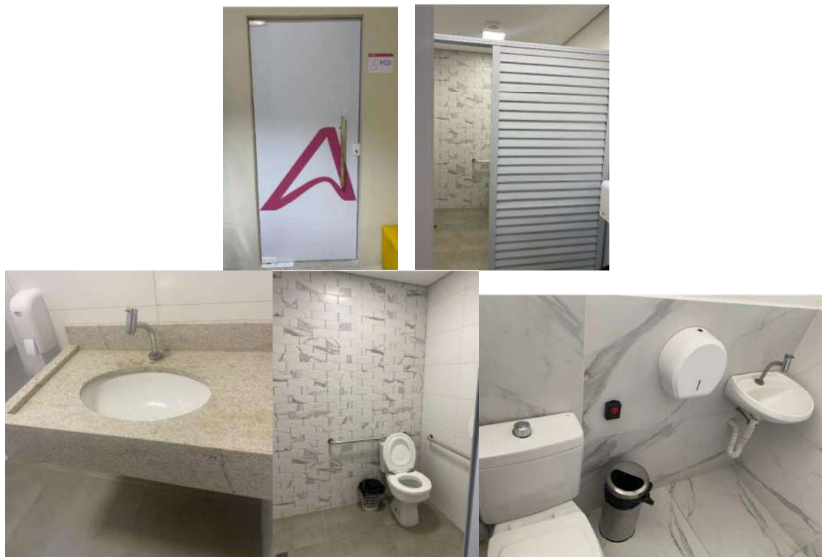
Figura 76 – Evidências de acessibilidade: adaptações e modernização dos banheiros para pessoas com necessidades especiais na unidade Patamares
