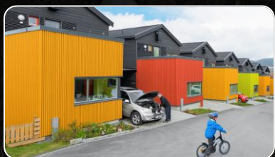
Støtte til forbedring av energitilstand i boligselskap
