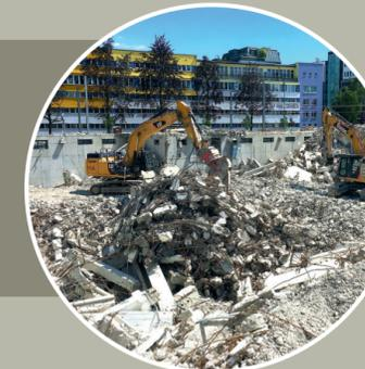
Bau- und Abbruchabfälle aus selektivem Rückbau von Gebäuden und technischen Bauwerken, Straßenaufbruch und Bodenaushub werden auf ihre Verwertbarkeit untersucht.
