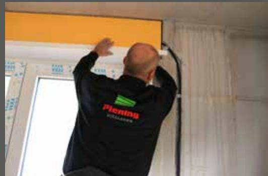
Der Montage-Rolladenkasten wird in einzelnen Teilen vor Ort nach der Fenstermontage inklusive der Rolladenpanzer und Antriebe montiert. Sondergrößen oder Sonderlösungen, wie z.B. Erker-Eckanlagen sind hierbei kein Problem. Der Montagerolladenkasten kann durch den Fensterbauer oder durch unser werkseigenes Montageteam gemessen und montiert werden.
