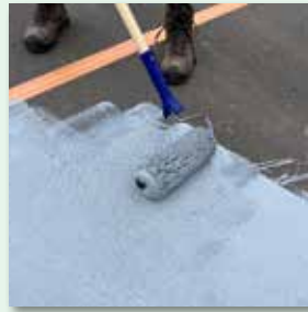
Mittels Malerrolle Material gleichmäßig aufrollen und verteilen.
