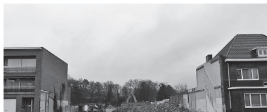
Aan de Kapelsesteenweg werden drie woningen voor site 'Bouwmaterialen Nuyens' gesloopt.
