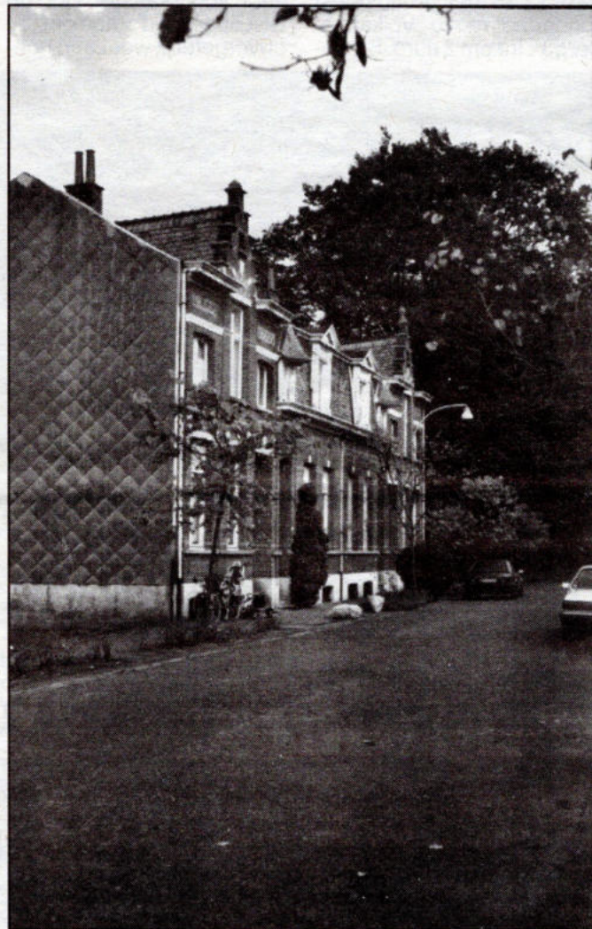
N.a.v. de werken aan het Antverpiagebouw zullen ook de huizen met trapgevel aan de Vroente, die een historische waarde hebben voor de wijk, door de gemeente Brasschaat gerenoveerd worden en een bestemming krijgen als sociale woningen
