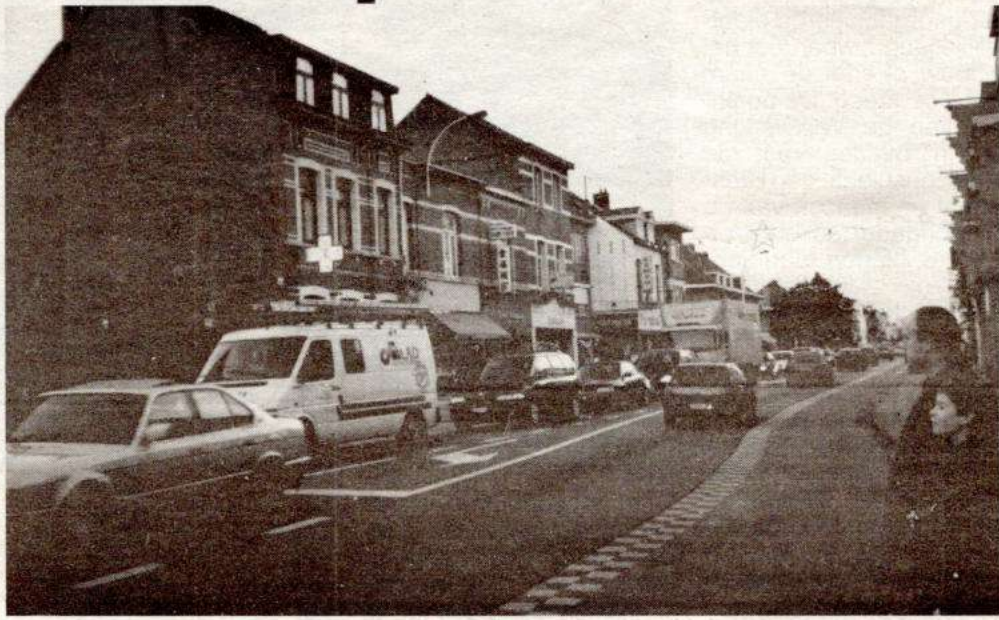
De Kapelsesteenweg is ontoereikend om het geweldig toegenomen volume verkeer te verwerken. Het is een échte dodenbaan.
