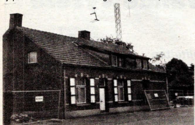
Dit oude boerderijtje, de laatste jaren een tweewoonst, zal verdwijnen als de nieuwbouwer achter klaar is. Het was één van de laatste herinneringen aan de tijd dat De Sterre het kasteeldomein van de familie Grisar was.
