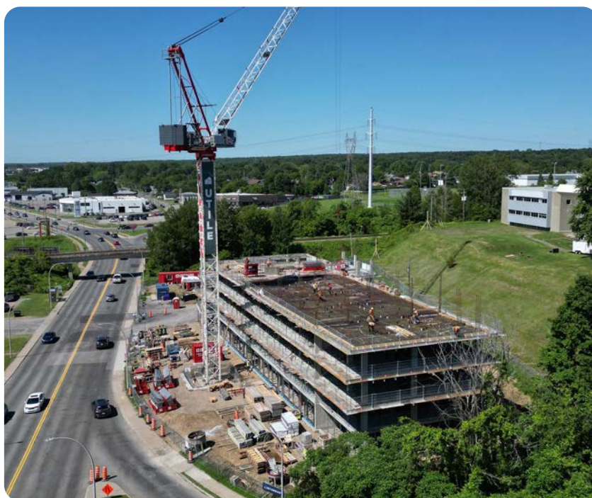
Chantier de la Canopée, Trois-Rivières
