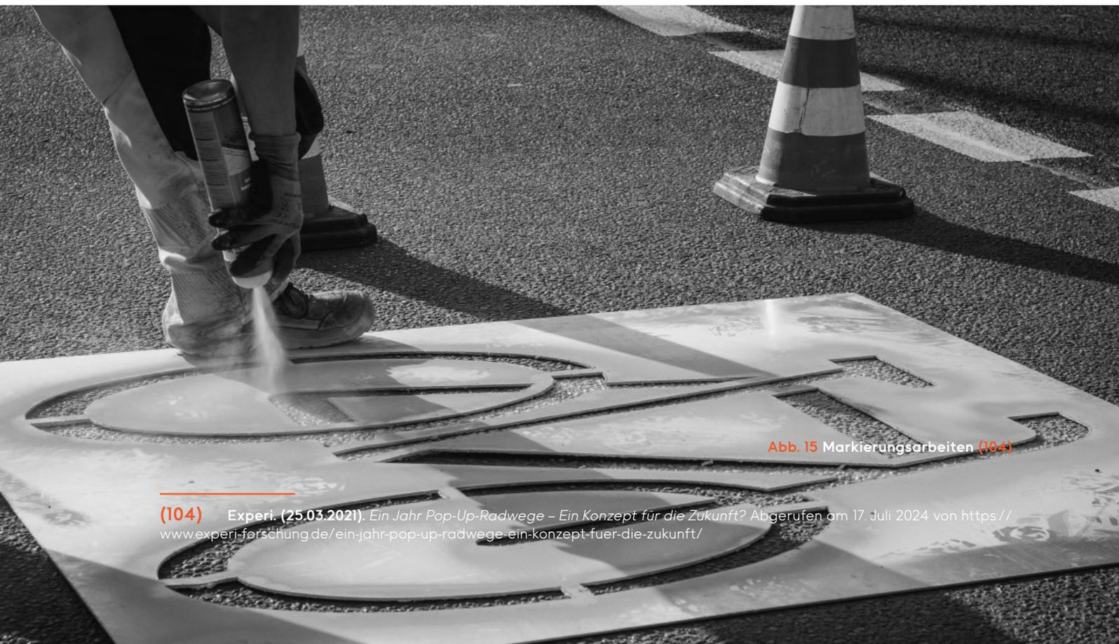
Abb. 15 Markierungsarbeiten (104)
