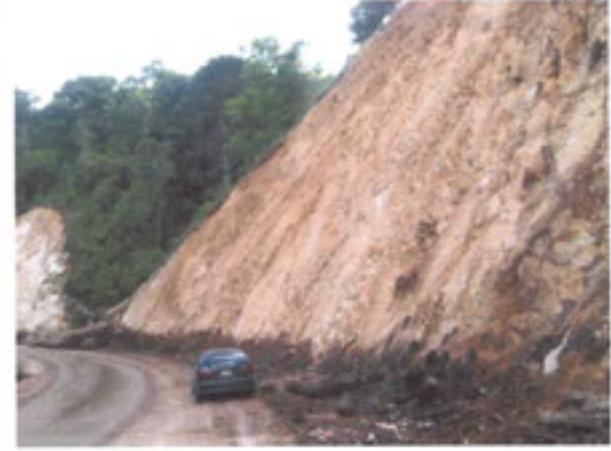
Caída de rocas (izquierda) y desprendimiento (derecha) en carreteras. Nótese el tamaño de la roca y del talud en relación con los vehículos. En los últimos inviernos, la carretera Interamericana ha sido de las más golpeadas por estos fenómenos, curiosamente, justo después de los trabajos de ampliación. Ambas fotos por M.Barillas
