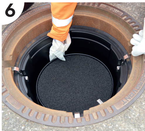
Hybrid-Aktivkohlefilter zusammen mit Siphon einsetzen.
