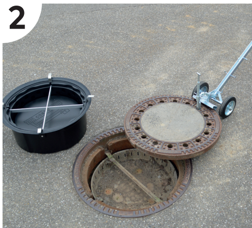
Schachtabdeckung mit passendem Schachtdeckelhe- ber entfernen.
