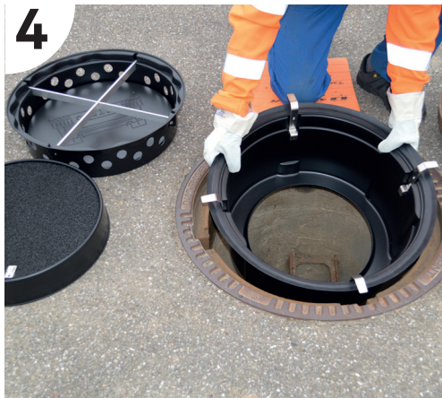
Grundkörper einsetzen. Bei Presspassung kann die Dicht- lippe mit Gleitfett eingeschi- ert werden.
