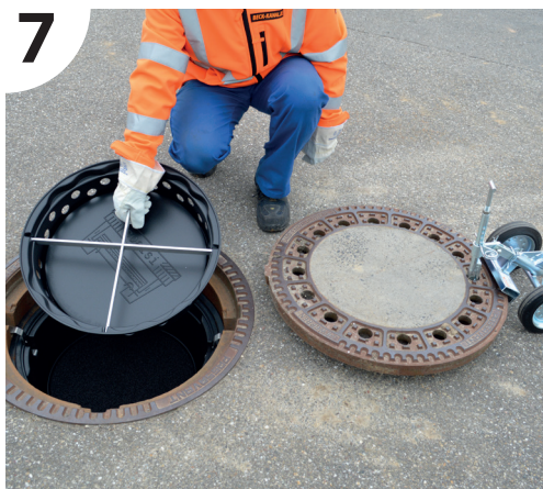
Laubfang in den Grundkörper einsetzen.
