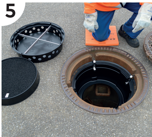
Draufsicht Grundkörper mit Dichtsistem
