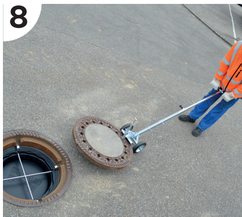
Schachtabdeckung mit Schachtdeckelheber wieder einsetzen
