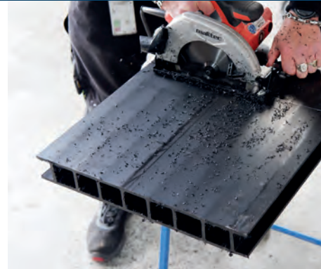
Zuschnitt der Platten
