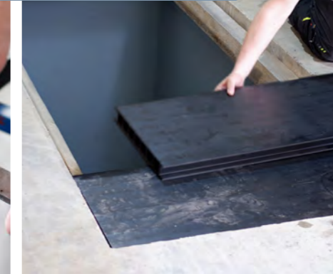
Werkzeuglose Verlegung
