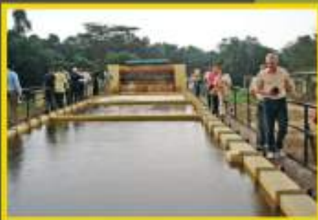
/// Recorrido por la planta de tratamiento de agua
