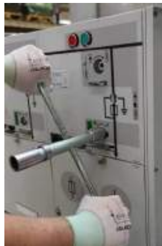
2. Lukk jordslutter ved å vri betjeningshåndtak urviseren.
