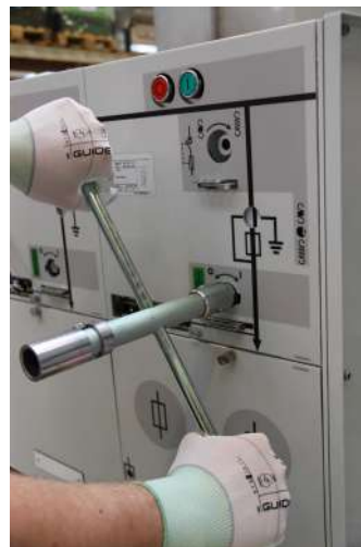
2. Lukk jordslutter ved å vri betjeningshåndtak urviseren.
