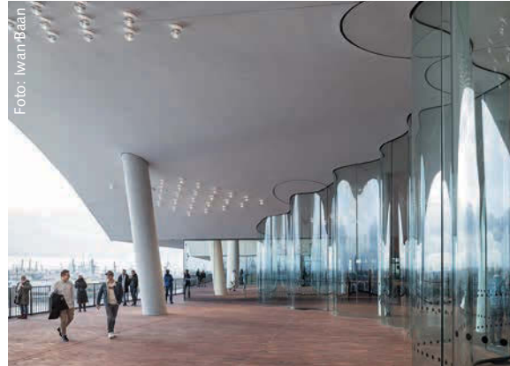
Auf der Plaza sind die Windschotts (rechts) zugleich ästhetische und funktionale Elemente.
