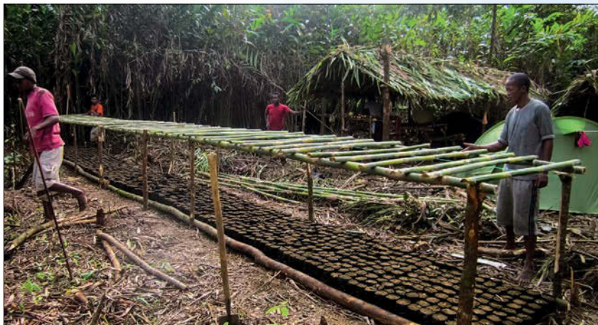
Im Rahmen eines „Eben! Holz“-Projekts auf Madagaskar werden Unterstände für Keimlinge von Edelhölzbäumen errichtet.
