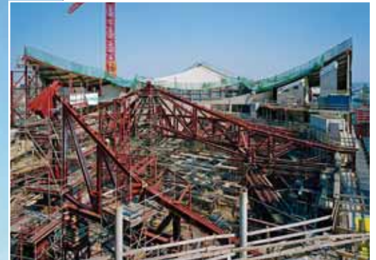
Nach über vier Jahren Bauzeit nimmt Hamburgs neues Wahrzeichen auf dem Kai-speicher A in der Hafencity zumindest von außen Gestalt an. Noch als rotes Gerippe ragt die Saaldachkonstruktion in den Himmel.
