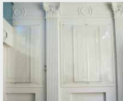
Microsorber (oben) verwendet dünne Folien, die an Federn aufgehängt werden.
