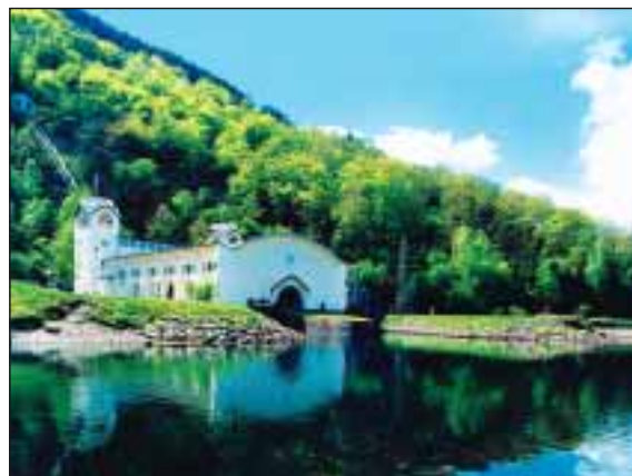
Das Kraftwerk vom Wasser aus gesehen.
