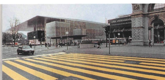
Blick auf das Kultur- und Kongresszentrum, das bis 1998 fertiggestellt werden soll.
