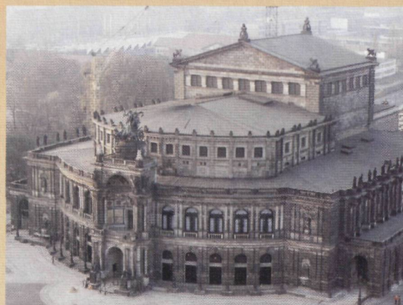
Zweimal Sempeleroper: 1985 im neuen Glanz (links) und 1977 zur Zeit der Grundsteinlegung zum Wiederaufbau (rechts)
