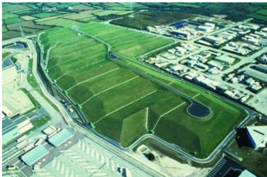
Figur 5-2 – Lav- og middelsaktiv overflatedeponi ved Centre de la Manche i Frankrike. Anlegget er lukket og er dekket av et taksystem
