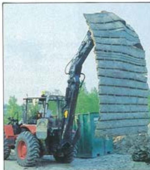
Grävaggregatet har stor lyfthöjd.
