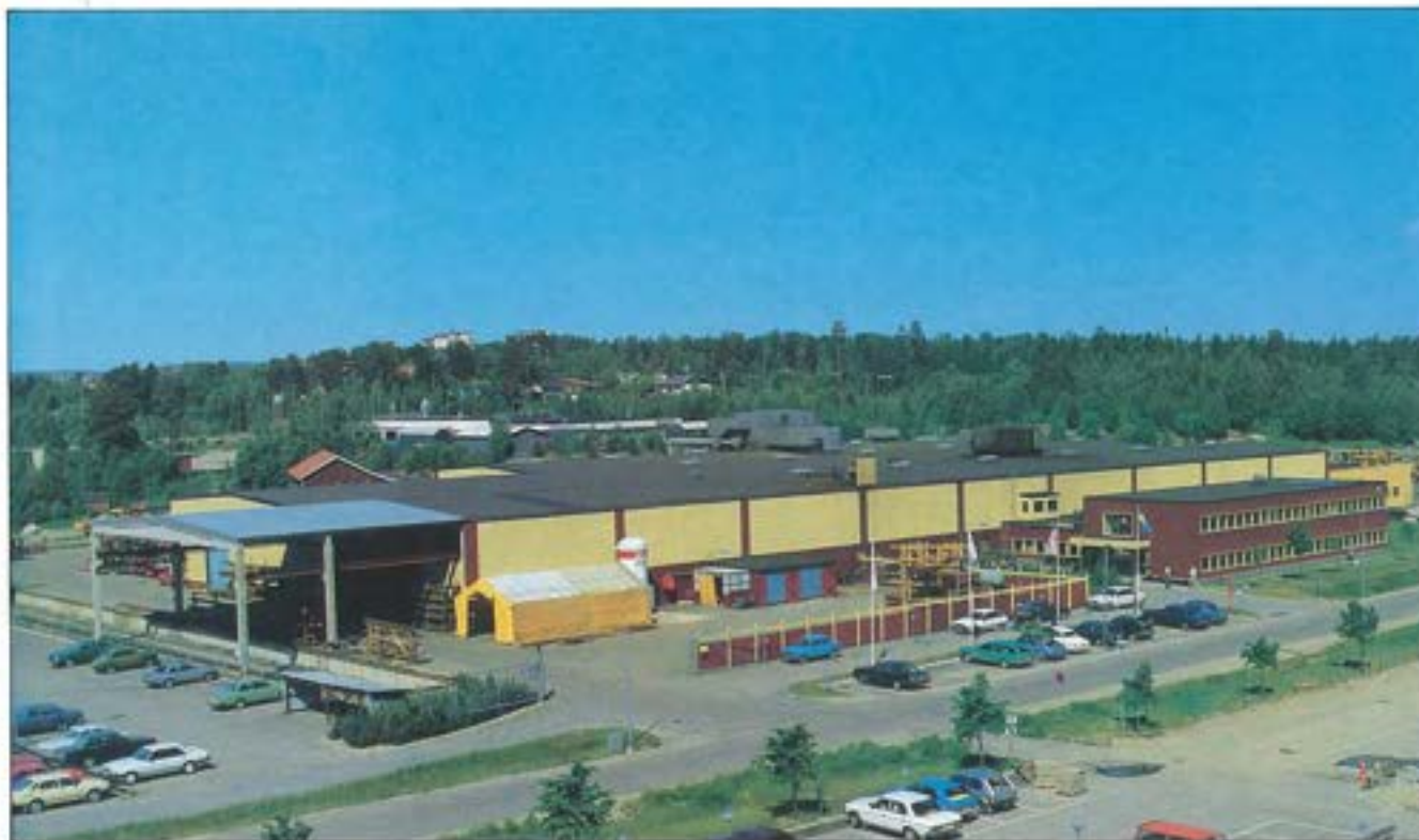
Huddig AB:s anläggning i Hudiksvall.
