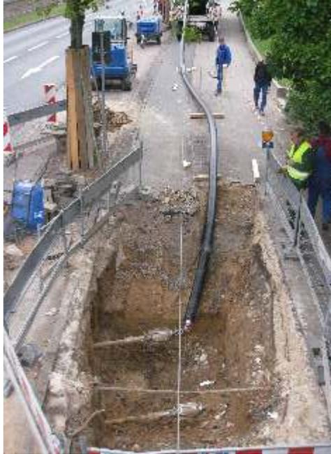
stoffmantel / Stahlmantel). Die werkseitig geschweißten und geprüften WIG Schweißnähte der flexiblen Rohrsysteme ermöglichen den vollständigen Verzicht von Schweißarbeiten vor Ort und gewähren hierbei das maximale Maß an Sicherheit. Hierbei können flexible Rohre verbindungs-frei in einer Länge von bis zu ein 1 Kilometer verlegt werden. Flexible Rohrsysteme ermöglichen auch die kostengünstigste
