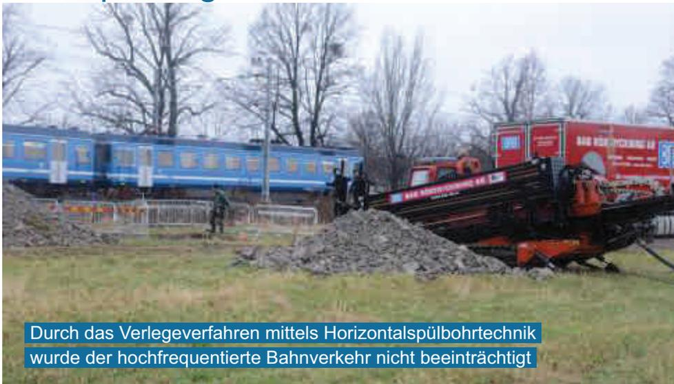
Durch das Verlegeverfahren mittels Horizontalspülbohrtechnik wurde der hochfrequentierte Bahnverkehr nicht beeinträchtigt
